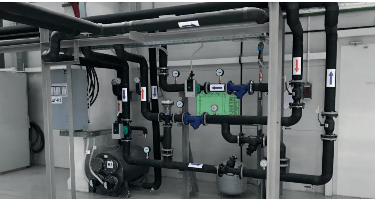
■ Данный узел является важной частью системы отопления и вентиляции оборудования. Его основная функция состоит в регулировании подачи горячей воды к теплообменнику, чтобы обеспечить оптимальную температуру приточного воздуха.
