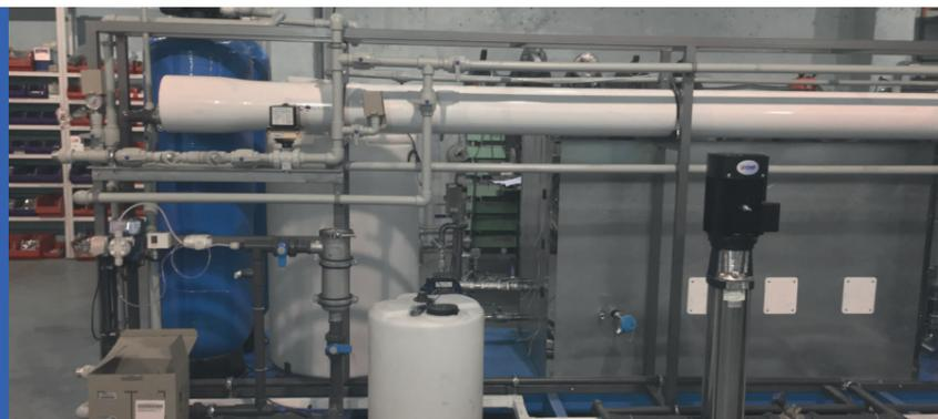
Деминерализованная вода - вода, из которой были удалены минеральные ионы в процессе обратного осмоса. Данный вид воды широко используется в промышленных и коммерческих целях благодаря своим уникальным свойствам, включая низкую электропроводность, низкое содержание минералов и высокую нейтральность pH.
