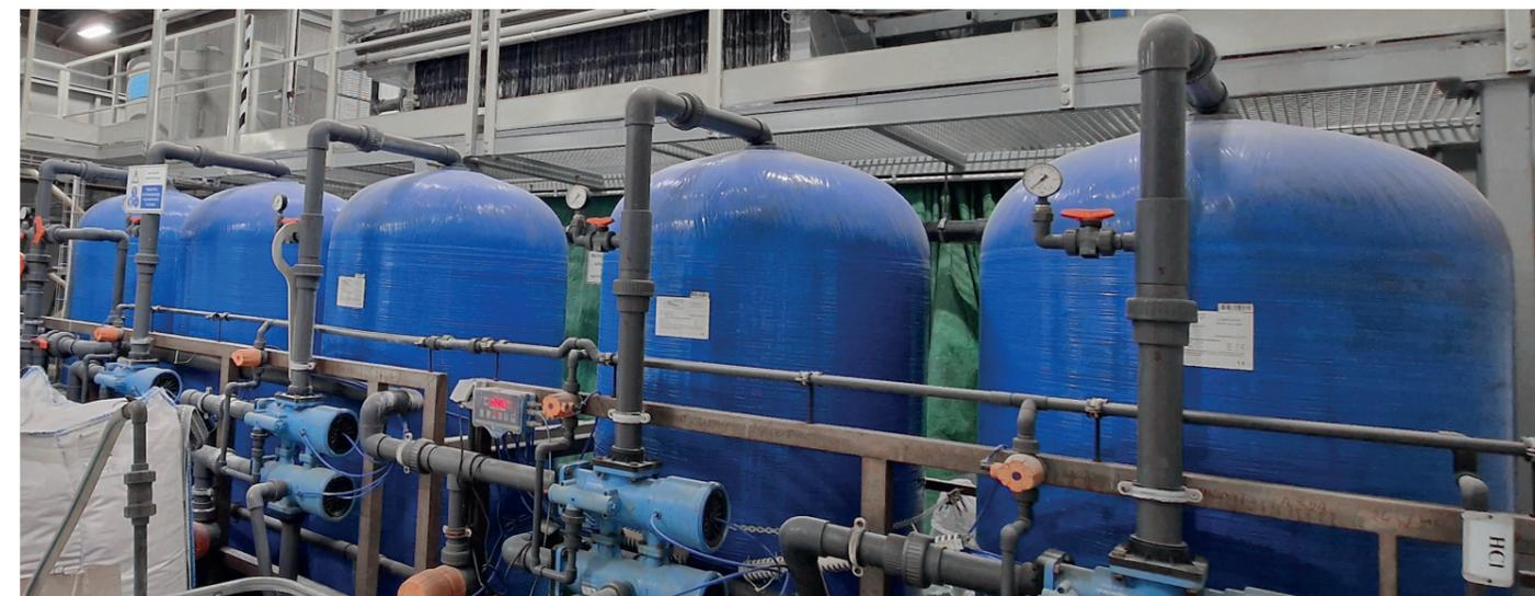
■ **Проточный реактор** - один из элементов локально очистных сооружений, используемый для удаления загрязнений из сточных вод. Вода поступает в реактор, где происходит взаимодействие загрязнений с химическим реагентом. Затем, с помощью коагуляции и флокуляции, образуются осадок и флокулы, которые легко отделяются от воды. Очищенная вода выводится из реактора, а осадок удаляется. Проточный реактор позволяет получать высокое качество очищенной воды и обладает высокой эффективностью очистки.
