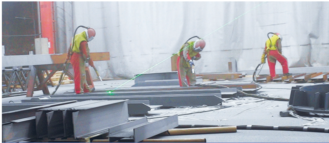
Для морских сооружений
